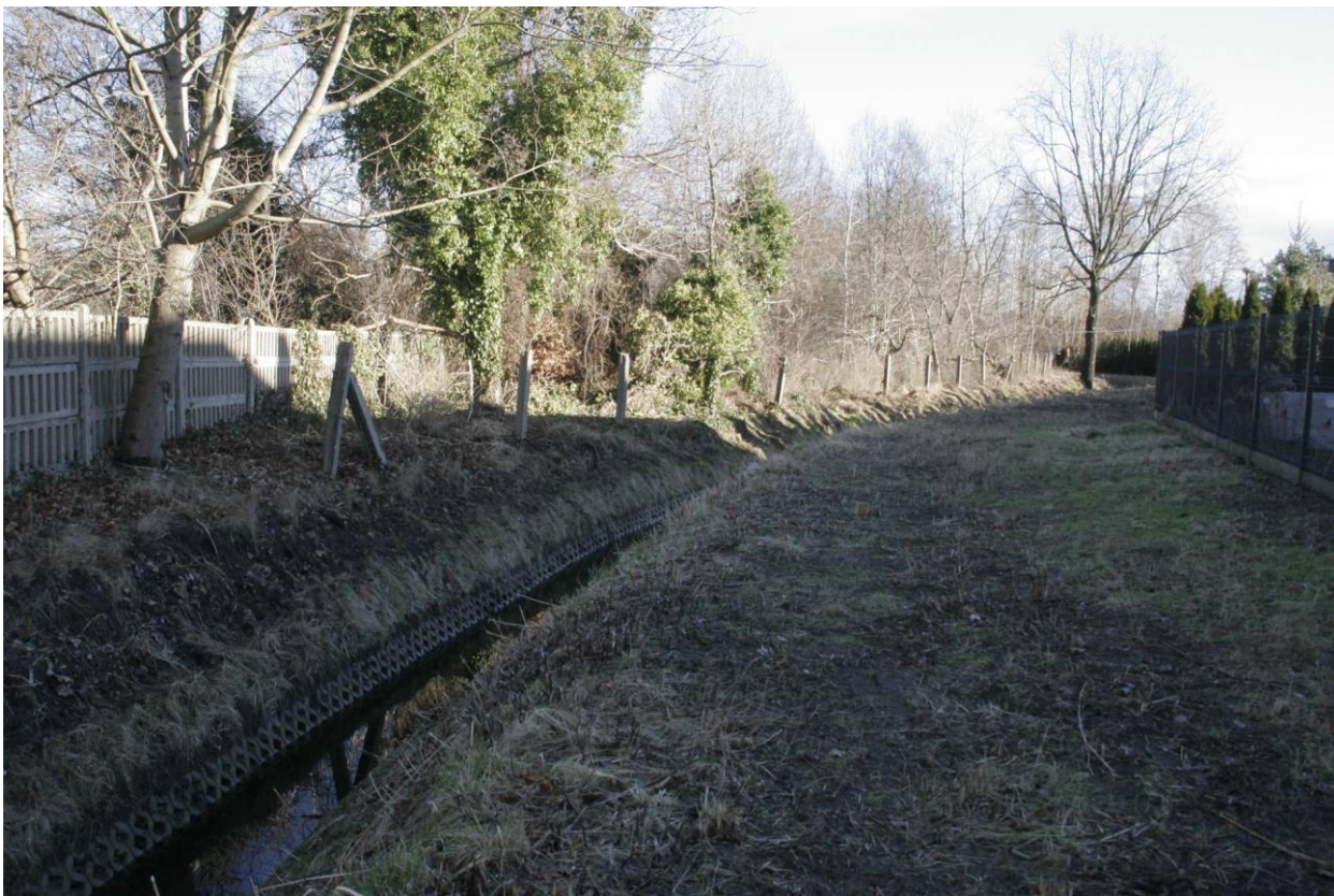
Koryto ciek na południe od analizowanego terenu – widok w kierunku wschodnim. Widoczny płot ogradzający analizowany teren.
