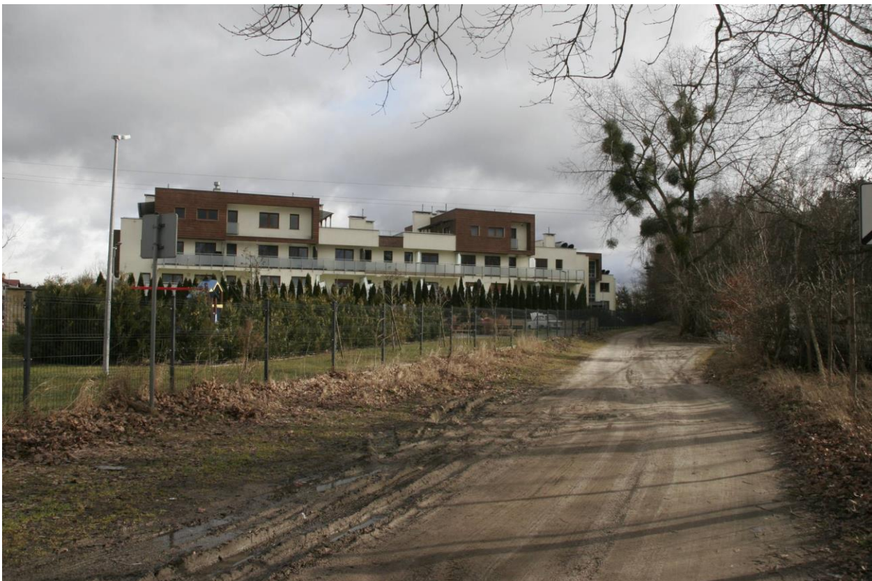
Przykład zabudowy wielorodzinnej w miejscowości Osielsko – wysokość zabudowy zbliżona do dopuszczanej w projekcie planu
