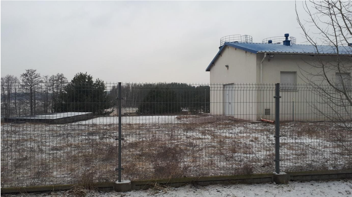
Rycina 2. Stacja uzdatniania wody Bożenkowo - widok
