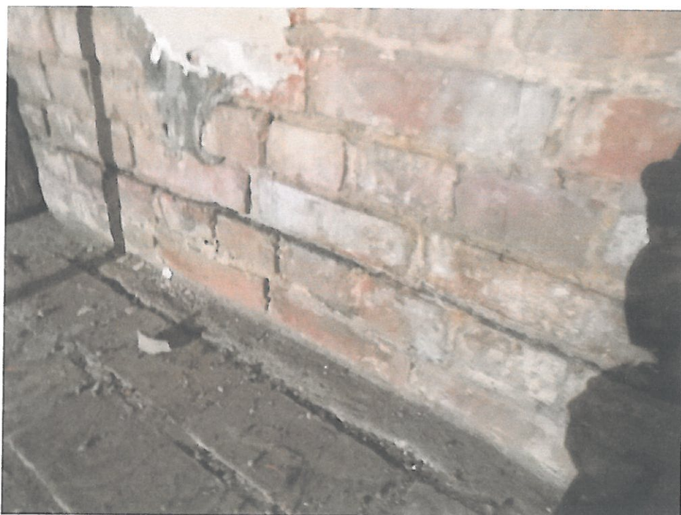
Zdjęcie nr 16 – Widoczna warstwa izolacji na drugiej warstwie cegły
