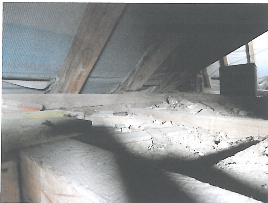
Zdjęcie nr 12 – Widok belek stropowych nad mieszkaniem na poddaszu
