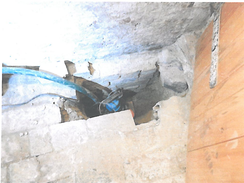
Zdjęcie nr 17 – Widoczny otwór/studzienka nr 1 i pompa w części niskiej budynku
