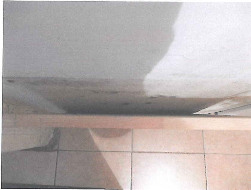
Zdjęcie nr 4 – Widok ściany przykrytej maskownicą
