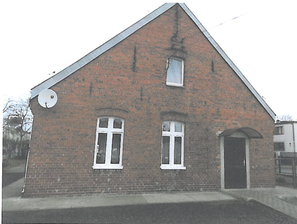
Zdjęcie nr 15 – Widoczne opaski wokół budynku : betonowa i z kostki betonowej
