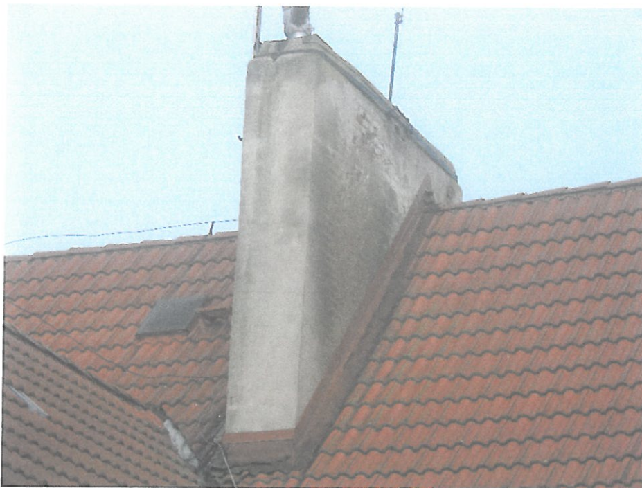
Zdjęcie nr 14 – Widok komina części wysokiej
