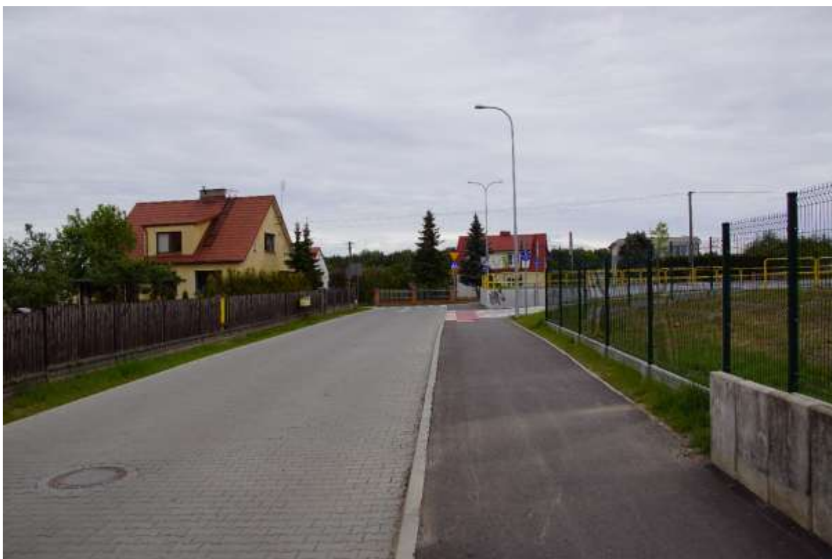
Ulica Topolowa w Maksymilianowie - długość odcinka 368,93 m. Wybudowano jezdnię asfaltową o szerokości 5,5 m, ciąg pieszo-rowerowy o szerokości 2,5 m o nawierzchni asfaltowej, oświetlenie i kanał telekomunikacyjny. Wartość zadania 1 389 147,33 zł. W przypadku tej ulicy nie było możliwości pozyskania środków zewnętrznych.
