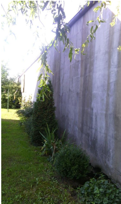
Fot. 2. Elewacja tylna (wschodnia)
