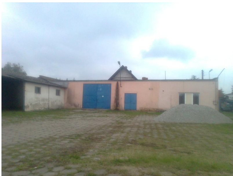
Fot. 2. Elewacja frontowa (zachodnia)
